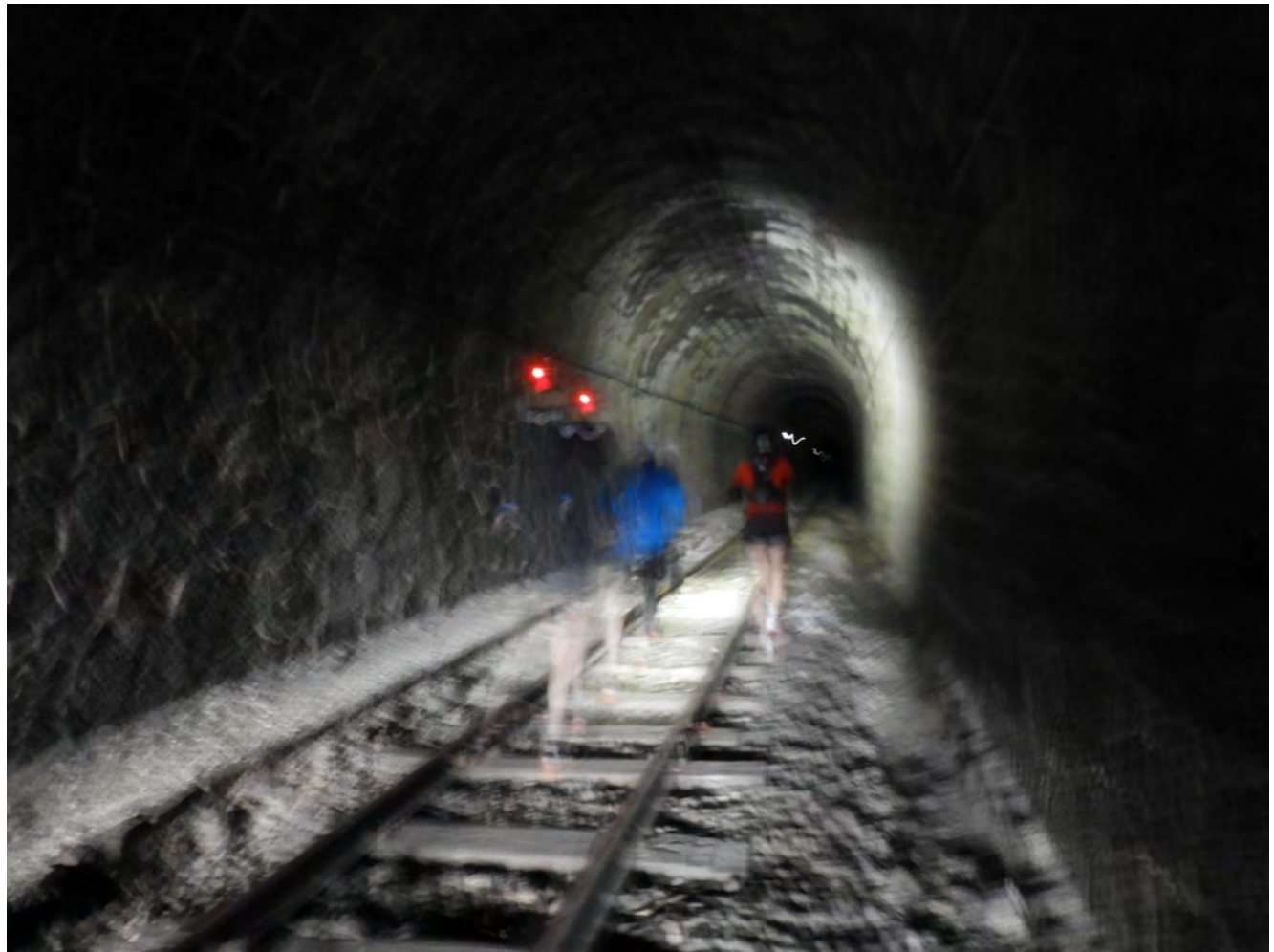
Entrada al famoso Túnel Mayor de 2.876 metros de longitud atravesando la Sierra de Alfabi
